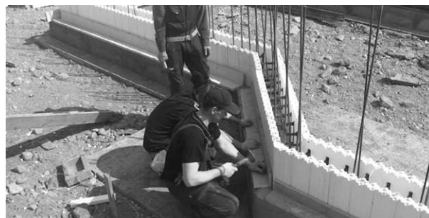
После установки всех блоков производится контроль размеров и фиксация стен с помощью фиксирующих досок, связанных между собой под прямым углом.
