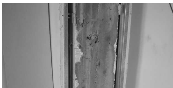
После монтажа каркаса на него крепятся листы ГКЛ по технологии возведения таких стен.
