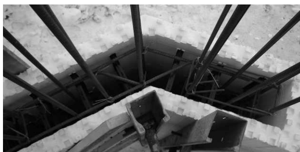
Возле проёмов, в прямых и эркерных углах, в примыкании и пересечении стен устанавливаются хомуты.
