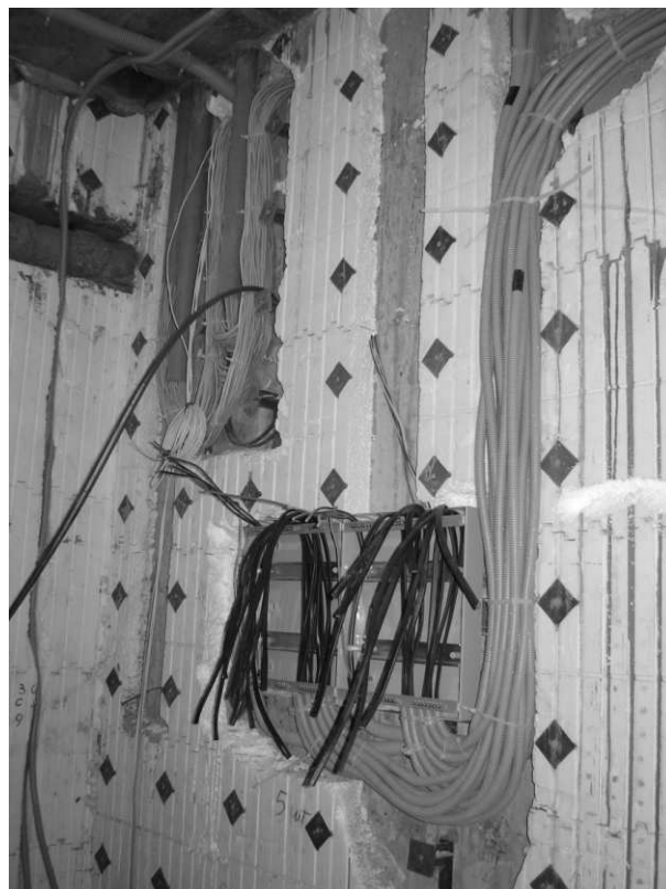
Монтаж всей электропроводки и арматуры осуществляется в соответствии с утверждёнными стандартами, правилами и спецификациями.
