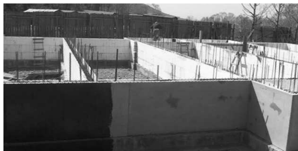
При выполнении стен цокольного этажа или подвала из блоков ТСТ-ДОМ необходимо принимать меры по гидроизоляции стен.
