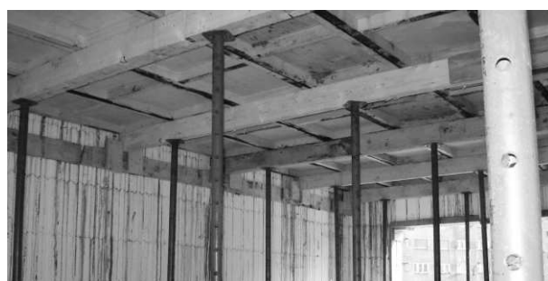
Для поддержания балок перекрытия используются типовые опорные системы.
