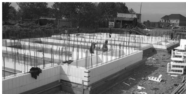
При монтаже придерживайтесь вертикальной линии расположения перемычек, одновременно выдерживая смещение между вертикальными швами.
