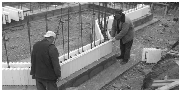
Установка блоков начинается с внешнего угла и выполняется в одном направлении.
