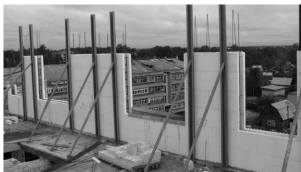
По плану разбивки стоек можно начинать установку, при этом должно быть смонтировано не менее 4 рядов блоков по высоте.
