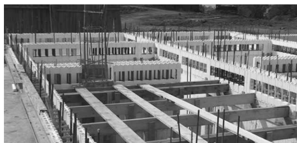
Производится подготовка опор под несущие балки с учётом их ширины и толщины опалубочных щитов.
