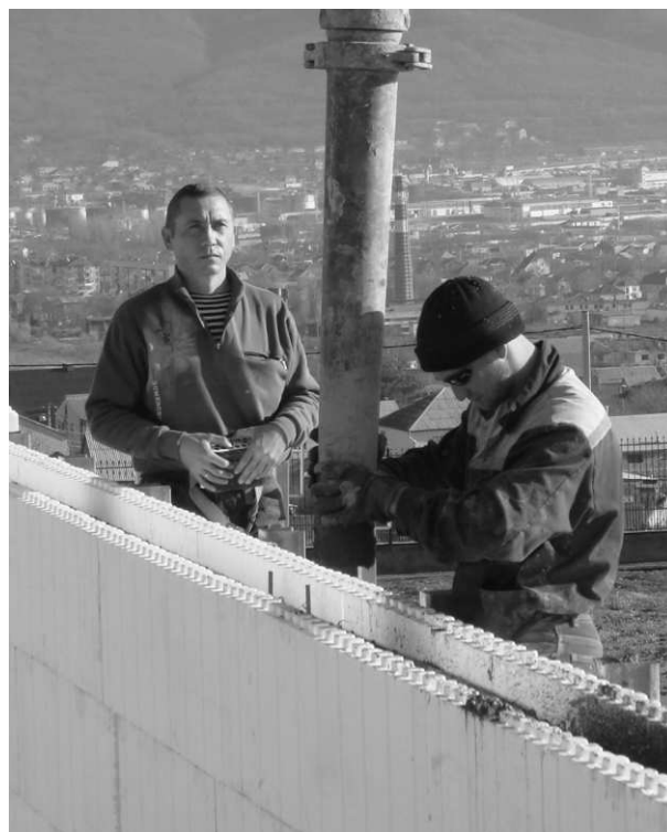
Для лучшей укладки бетона в обязательном порядке необходимо провибрировать бетон.
