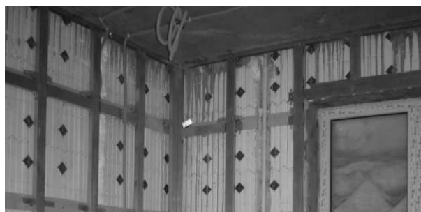
Стальные полосы каркаса крепятся к фанерной полосе заблаговременно закреплённой к пластиковым перемычкам блоков.
