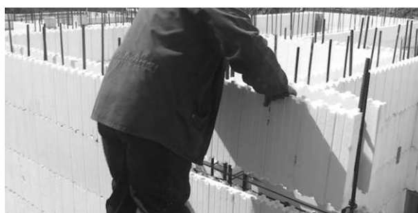
Блок устанавливается с пропуском вертикальной арматуры между перемычками. Блок плотно фиксируется соединительными пазами.
