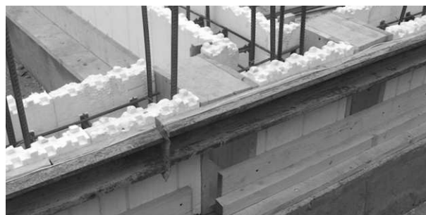
В местах, где будут заводиться коммуникации, устанавливаются короба. После контроля размеров и углов блоки фиксируются с фундаментом доской.
