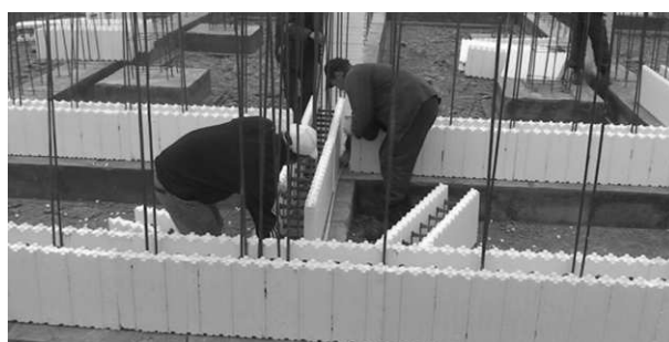
В местах пересечения стен или Т-образного примыкания соблюдаются правила монтажа блоков.
