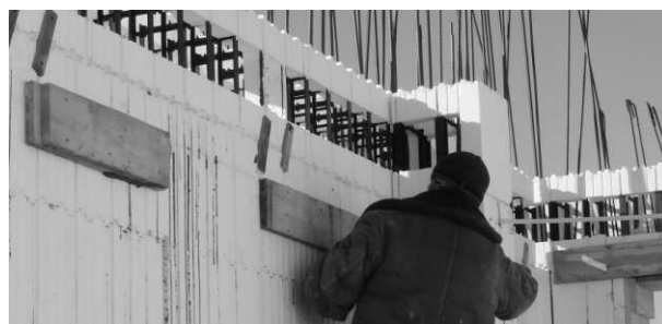
Перед монтажом перекрытия монтируется ряд блоков с 200 мм прорезью в панели блока, обращенной внутрь.
