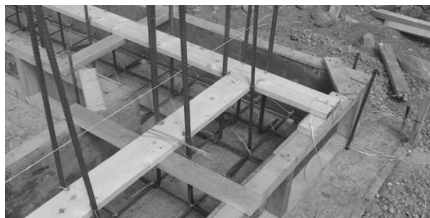
Собранный элемент фундамента готовый к заполнению бетоном.
