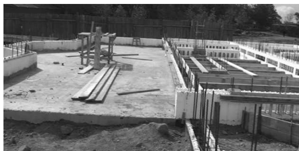
При обратной засыпке пазух грунтом возможно нарушение целостности мембраны, поэтому рекомендуется защищать гидроизоляцию ТСТ листом ППС толщиной S=0-50 мм.
