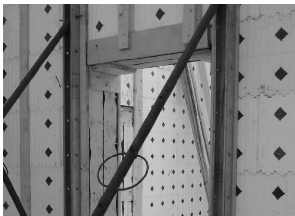
Прикрепите шурупами доску (25×150 мм) по всему периметру проёма с обеих сторон окна и двери. Это позволит обеспечить выравнивание поверхности стены ППС по отношению к деревянному блоку.
