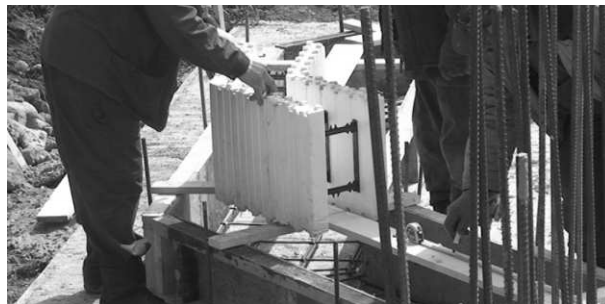
В местах использования угловых или эркерных блоков производится контроль соответствия выходящей арматуры и перемычек блока.
