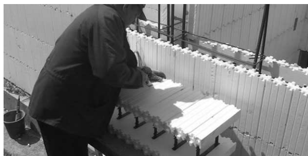
Резку блоков по вертикали осуществлять посередине между пластиковыми перемычками.
