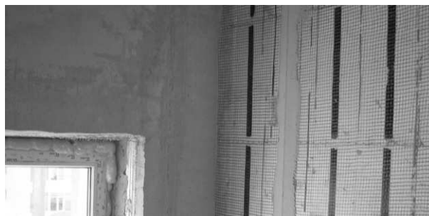
При использовании цементно-песчаной штукатурки крепление стальных штукатурных сеток к наружным поверхностям опалубочных элементов осуществляется с помощью скоб.
