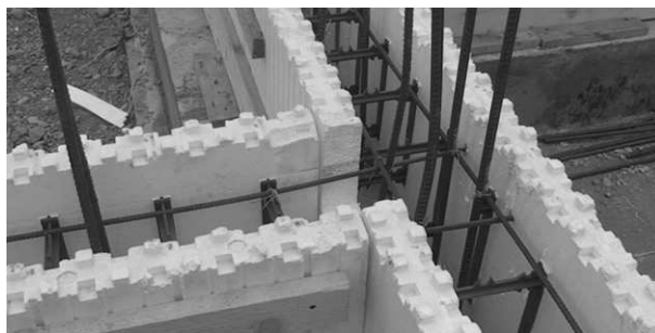
При монтаже примыкающих или пересекающихся стен необходимо состыковывать блоки так, чтобы шипы и углубления продолжали чередоваться.
