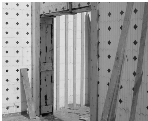
Дверные и оконные проёмы легко выполняются путём установки деревянной коробки такого же размера, как и чистый проём.
