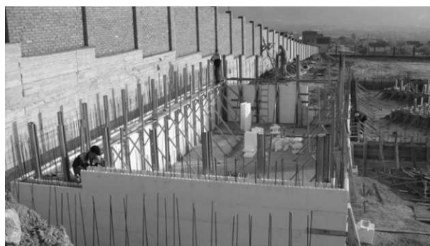
По завершению работ установки выравнивающей системы убедиться в прямолинейности стен, а перед бетонированием отклонить верхнюю часть стойки на 5 мм в сторону стяжки.
