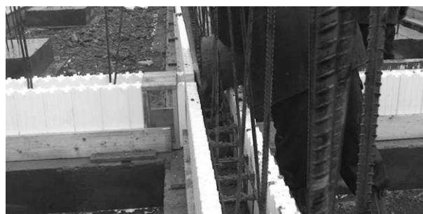
Во избежание смещений первый ряд проливается бетоном вручную. После закрепления приступают к возведению стен.
