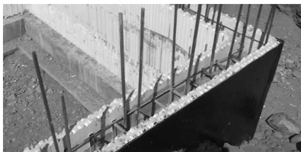
Бетонирование должно производиться до середины блока последнего перед перекрытием ряда.
