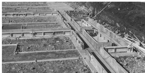
После застывания бетона основы производится осевая разметка и разметка размещения границ фундамента, по которым выставляются щиты опалубки.
